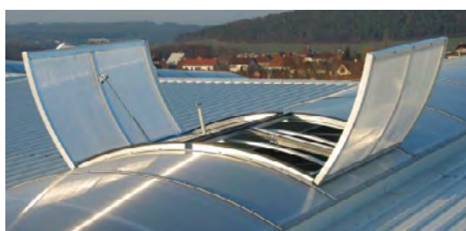
Люки дымоудаления в световых полосах
