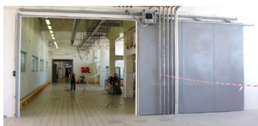
Откатные противопожарные ворота
